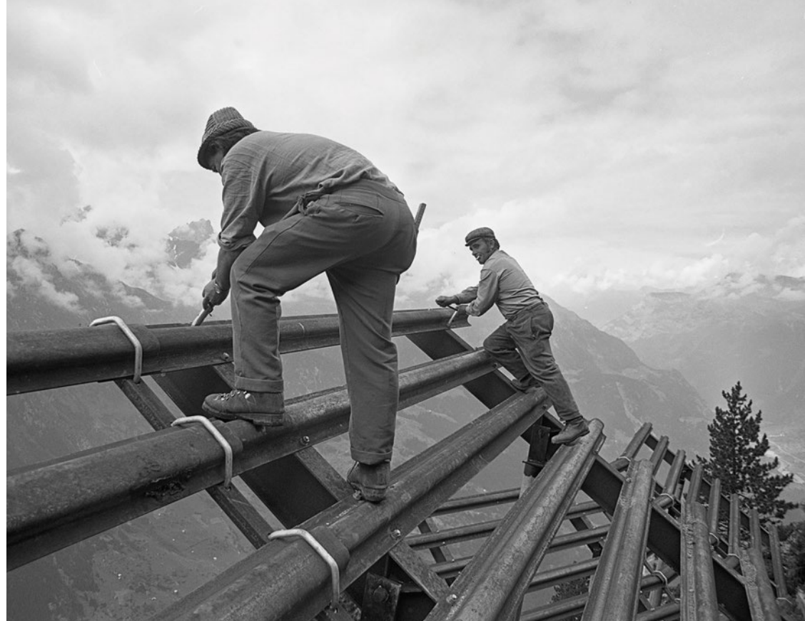
Gurtellen, Lawinerverbauungen, 1974–1976. Foto: Heinz Baumann
