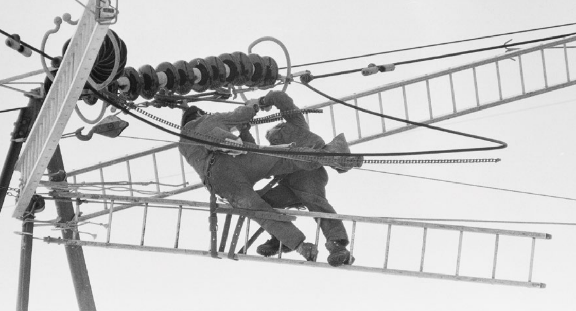
Dübendorf, Fällanden, Hochleitungsbau, 12.02.1973. Foto: Hans Witschi
